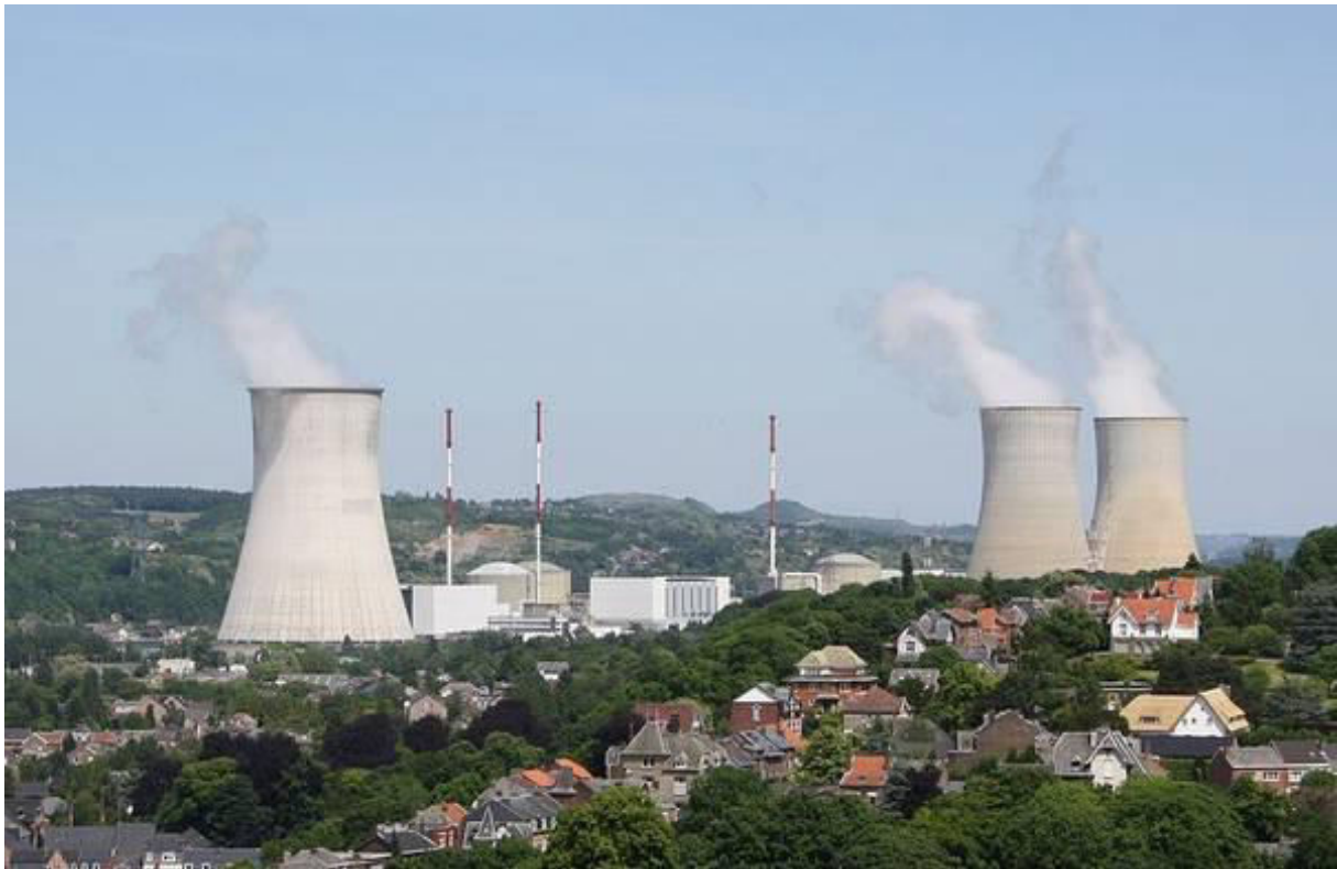
Atomkraftwerk im belgischen Tihange - Foto: Hullie | Wikipedia.de
